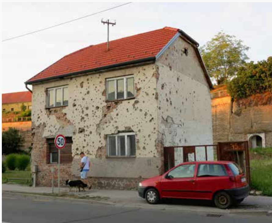
← (fig. 36) Centre-ville de Vukovar, photographie prise durant l'enquête de terrain entre mai et juillet 2022.
