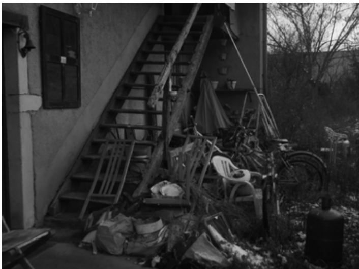
L'escalier à côté de la porte d'entrée (2025)
