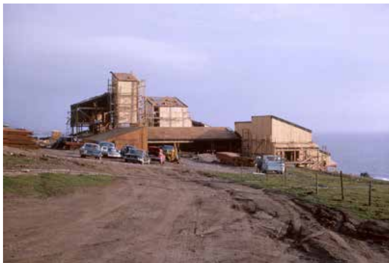
Première copropriété en construction, vue du nord, Lawrence Halprin collection, 1965.
