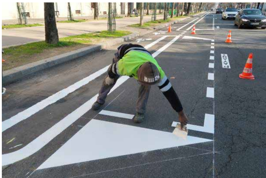
Traçage d'un marquage au sol de signalisation routière.
