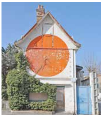
Vestige d'un rond rouge sur une ancienne station-service.
