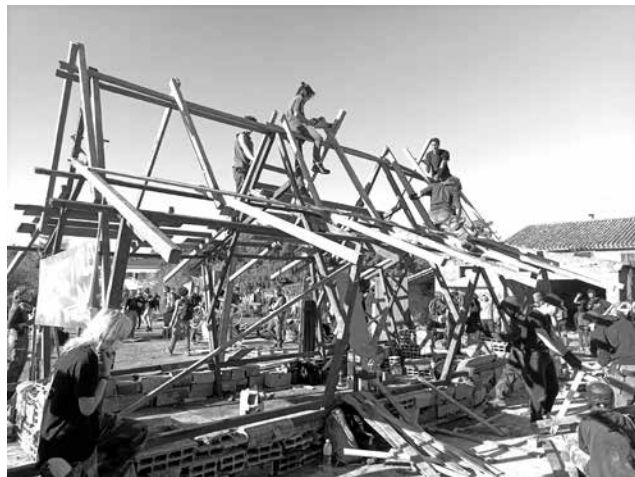
« Construction d'une charpente pour une future Cremzad. » Entre Castre et Toulouse sur le tracé de l'A69, 2023
